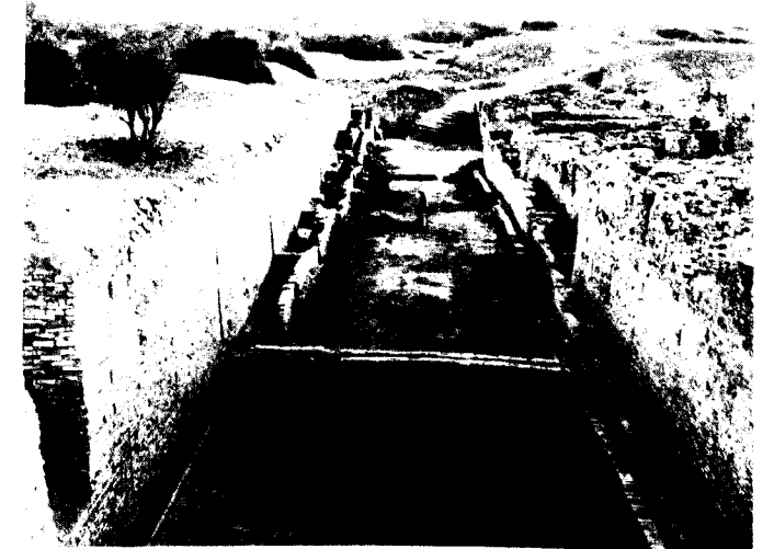
(d) FACING SOUTH.
