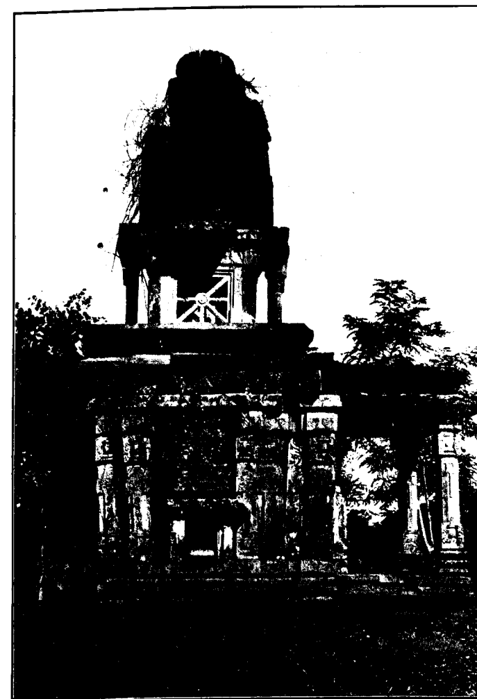
b. DEOGARH : KURAIYA BIR TEMPLE BEFORE REPAIR.
