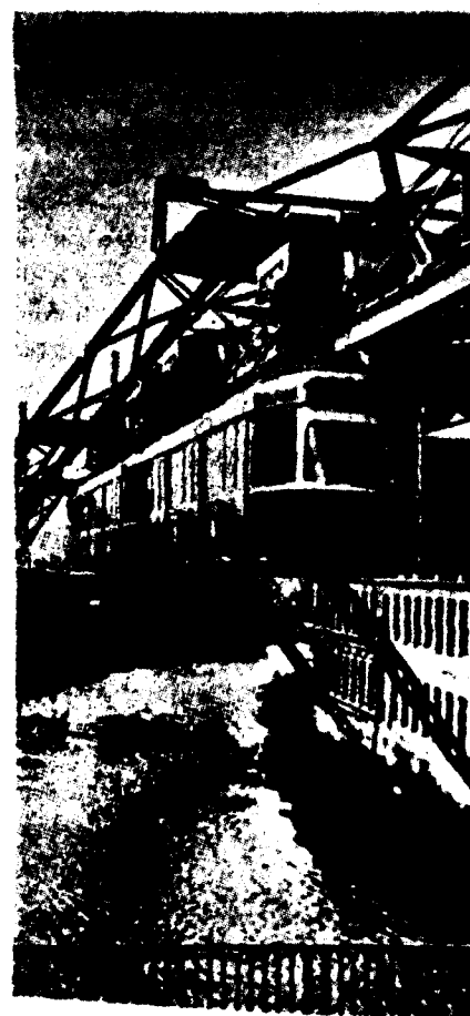
Fig. 2. Wuppertal Schwebebahn Monorail.
