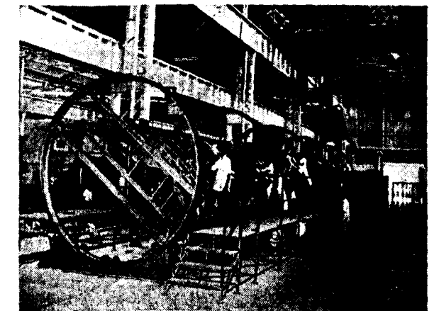
Fig. 19. Roof jig.
