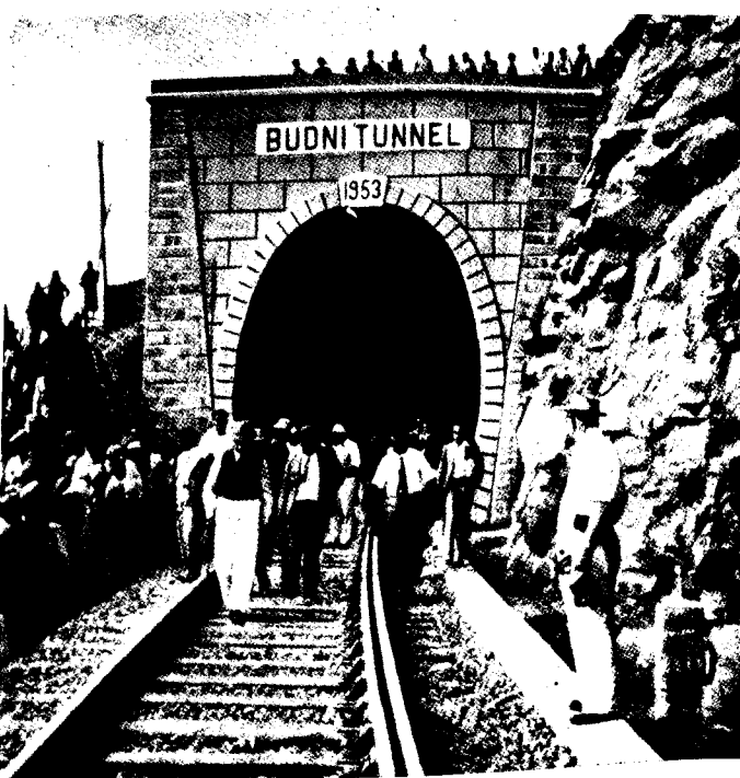
The Budni Tunnel.
