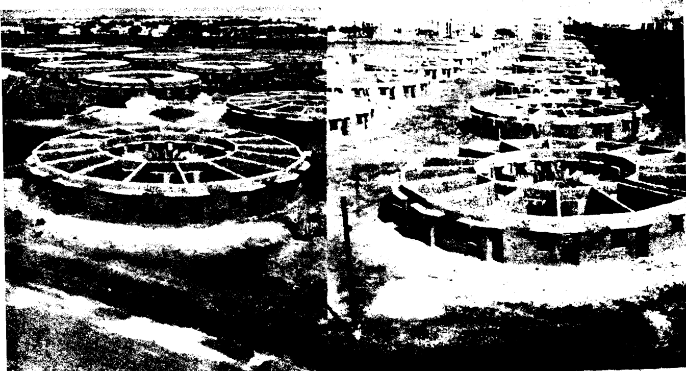
தமிழ்நாடு வீட்டு வசதி வாரியம் சென்னை அருகிலுள்ள 'பாடி' ஏரியிலும், செங்கல்பட்டு மாவட்டம் கூடலூரிலும் "வட்ட வடிவு வீடுகள்" கட்டியுள்ளது. ஒவ்வொரு வட்டத்திலும் 16 வீடுகள் இருக்கும்.
