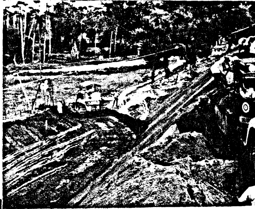
▲ செம்பரம்பாக்கம் ஏரியின் கரையை பலப்படுத்துவதற்காக லாரிகளில் மண் கொண்டு வந்து குவிக்கப்படுகிறது. தவிக்கப்பட்ட மண்ணை புல்டோசர் மூலம் நிரவியும் அழுத்தியும் கரைக்கு வலுவூட்டப்படுகிறது.
