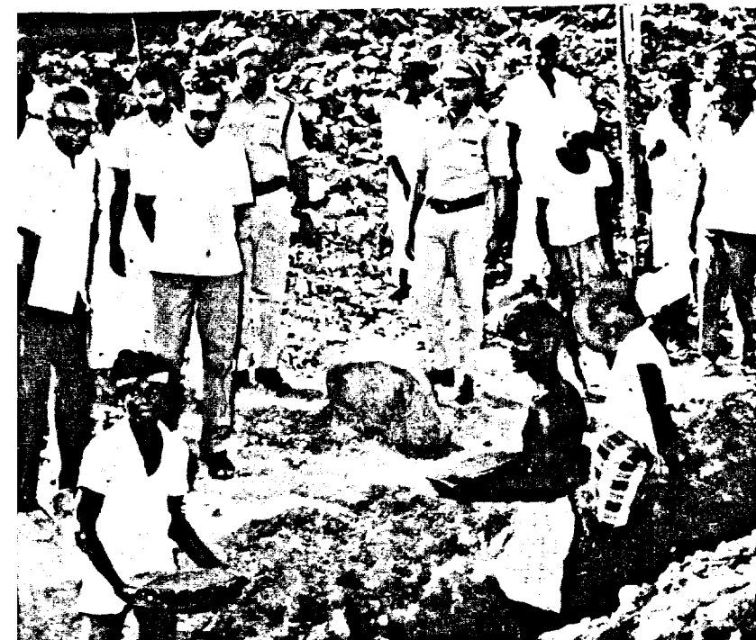
▲ செம்பரம்பாக்கம் ஏரிக்கரையில் 400 அடி நீளத்திற்கு 10 அடி ஆழத்திற்கு வெடிப்பு ஏற்பட்டதால் கரை உடைந்து விடுமோ என்று அப்பகுதி மக்கள் பயந்தனர். அப்பகுதியைத் தமிழ்நாடு ஆளுநரின் ஆலோசகர் திரு. ஆர். வி. சுப்பிரமணியன் அவர்கள் 5-12-76 அன்று பார்வையிட்டார். கரையில் ஏற்பட்ட வெடிப்பில் மணல், கிராவல், சிமெண்ட் ஆகியவற்றைக் கலந்து போட்டு கரைக்கு வலுவூட்டப்படுவதைப் பொதுப்பணித்துறையின் நீர்ப் பாசனப் பிரிவுத் தலைமைப் பொறியாளர் திரு. பி. கே. வேதநாயகம் அவர்கள், ஆளுநர் ஆலோசகருக்கு எடுத்துரைத்தார்.
